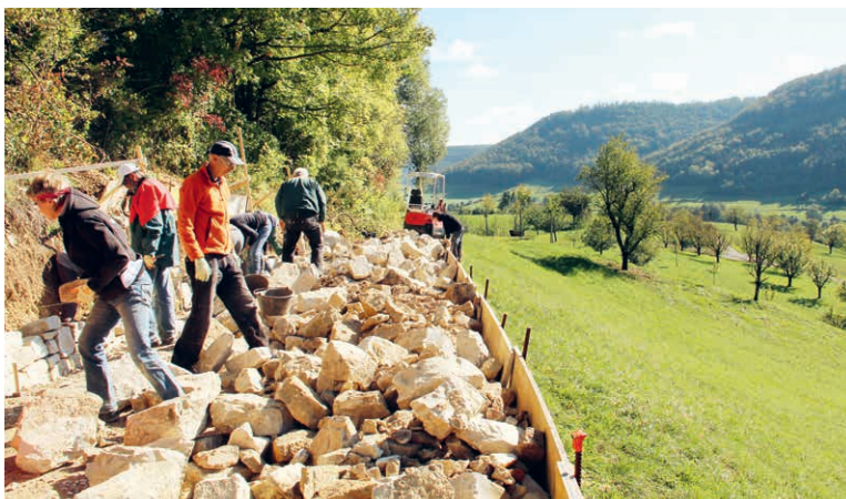
Bau einer Trockenmauer im Jurapark Aargau
